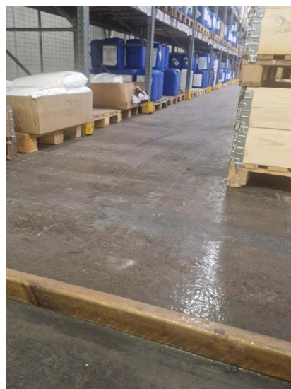
Figur 6 Två exempel på lokala invallningar vid Provexas lagerhållning.
